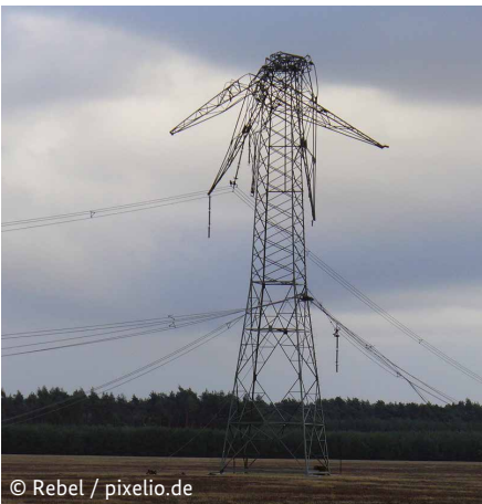
Sturmschaden durch den Orkan Kyrill im Jahr 2007
